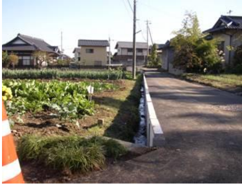
水路と道路はすっきりしたが・・・
